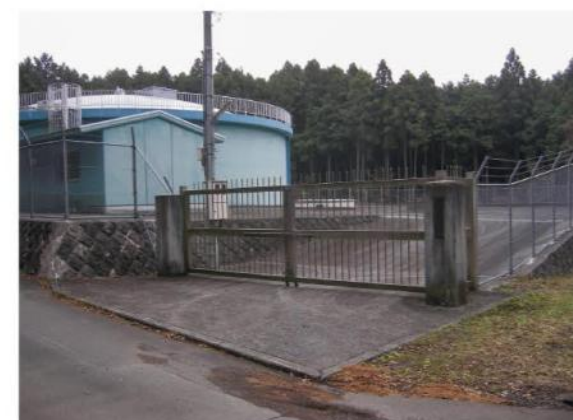
堀之内配水池
