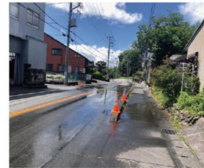
道路上での漏水 地中の水道管が破損し、水が道路に 噴出している状態
