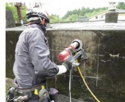
水道施設の耐震診断
