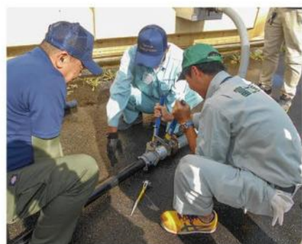
応急仮設配管の設置訓練
