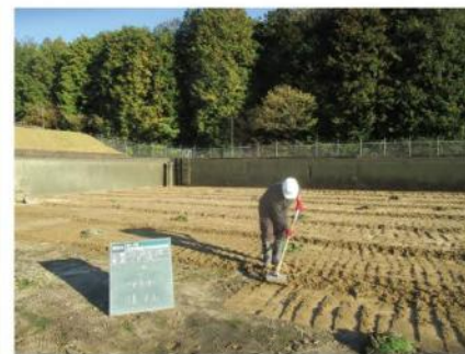
浄水場の管理 ろ過池の砂の入替作業は計画的に実施
