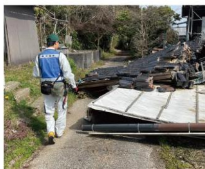
珠洲市での水道管の破損調査
