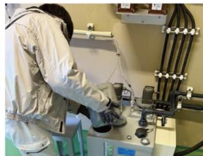
薬品の補充 消毒用の次亜塩素酸ナトリウム (塩素剤)は職員が手作業で補充
