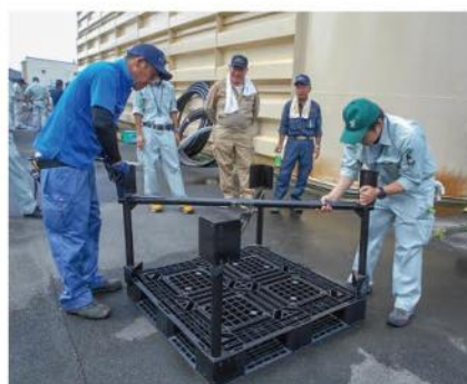
組立式給水タンクの設置訓練
