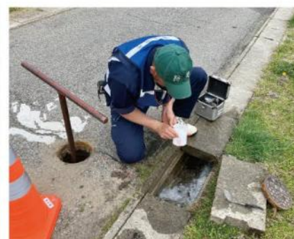
珠洲市での水道管修繕作業
