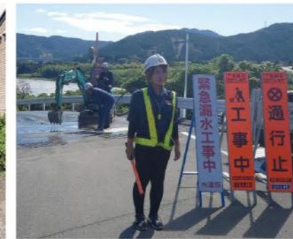
緊急漏水修繕工事 地域の水道業者さんを行う水道管の 漏水箇所の修繕工事
