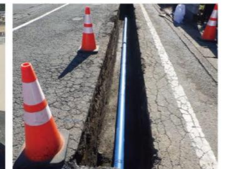
水道管の更新工事
