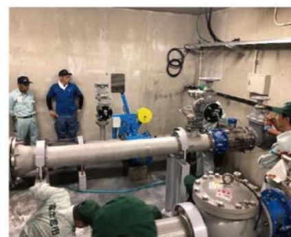
水道施設の操作訓練
