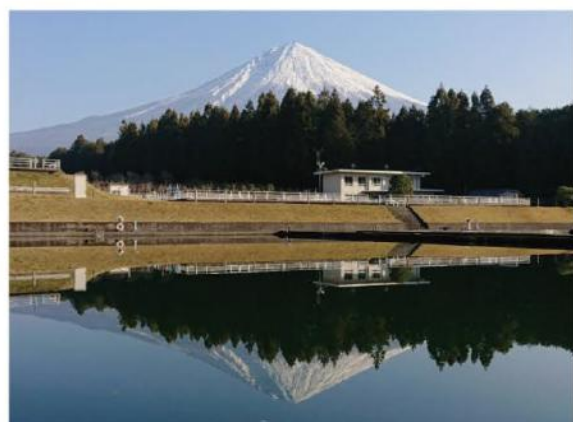
市内で最も多くの水道水を作る北山浄水場
