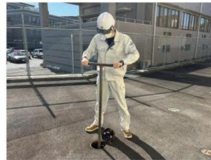
バルブなどの水道施設操作 水道管内の水量を調整
