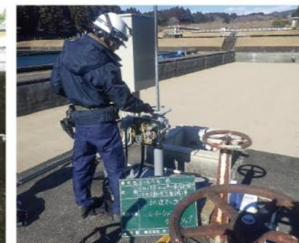
水道施設の更新工事
