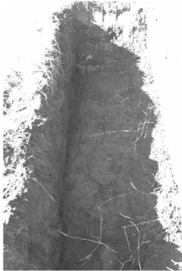
写真 27 トレンチ完掘状況
