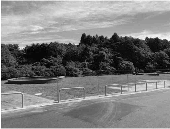
写真3 公園・排水施設等整備
