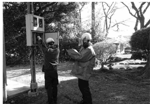
写真 13 漏電検査（富士山本宮浅間大社）
