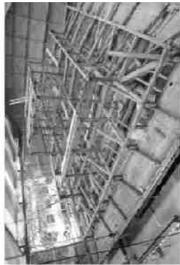
解体作業中 (覆屋の骨組の解体)
