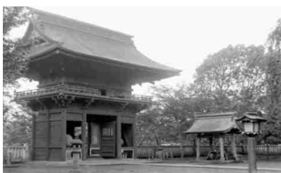
7. 旧手水舎及楼門
