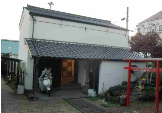
写真 10 吉澤家住宅煉瓦蔵（外観）
