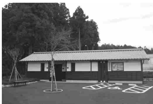
写真9 山宮浅間神社の便益施設（案内所・トイレ）
