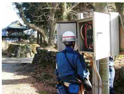
写真 15 北山本門寺の漏電検査
