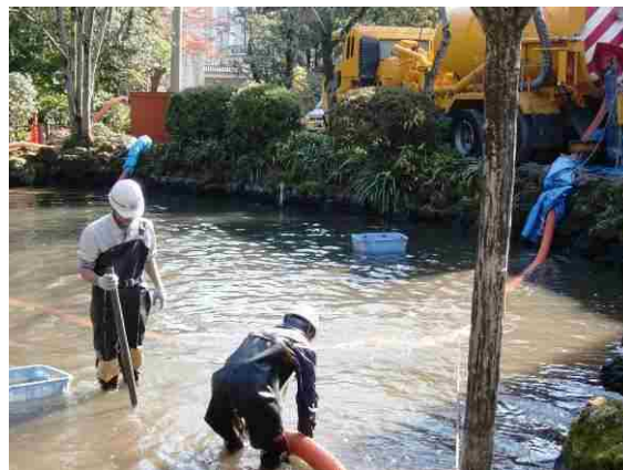
写真8 湧玉池凌濁作業
