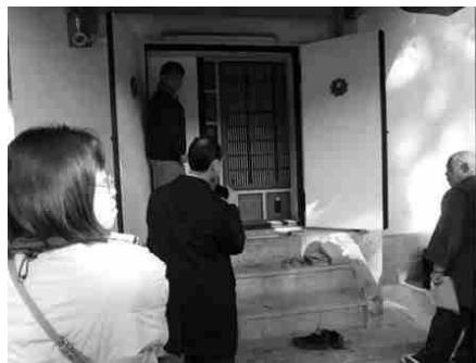
写真 14 御宝蔵修理状況
