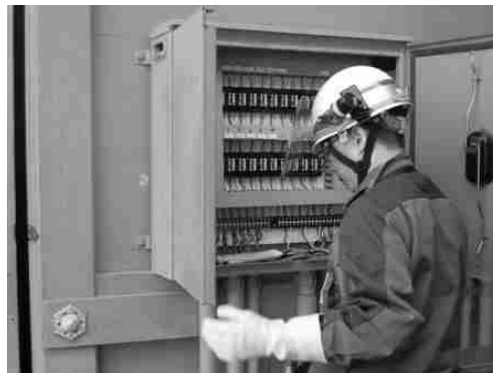
写真 12 浅間大社漏電検査
