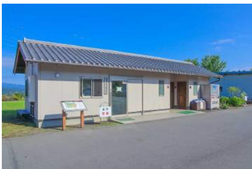
休憩室とトイレ
