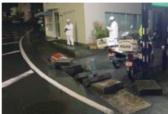
▲城山公園東側道路の側溝の溢水 いつせい に対応
