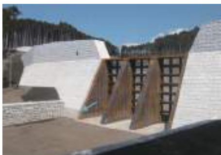
▲えん堤で土石流により流出する土砂や立木を受け止め、多量の土砂などが下流に一気に流れないように調節するとともに、河床や河岸の浸食を防ぎます。
