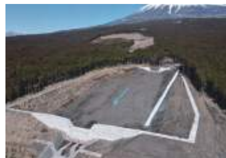
▲遊砂地では川幅を広くして土砂の流れを弱め、下流への流出を防いでいます。
