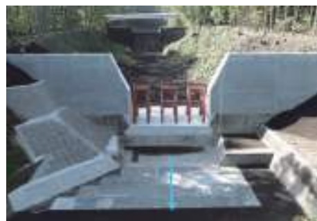
▲えん堤で土石流により流出する土砂や立木を受け止め、多量の土砂などが下流に一気に流れないように調節するとともに、河床や河岸の浸食を防ぎます。
