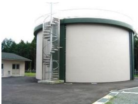
上井出第1配水池
