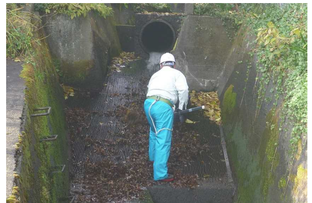
取水口の清掃（内野取水場）
