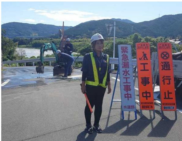
漏水修繕工事現場
