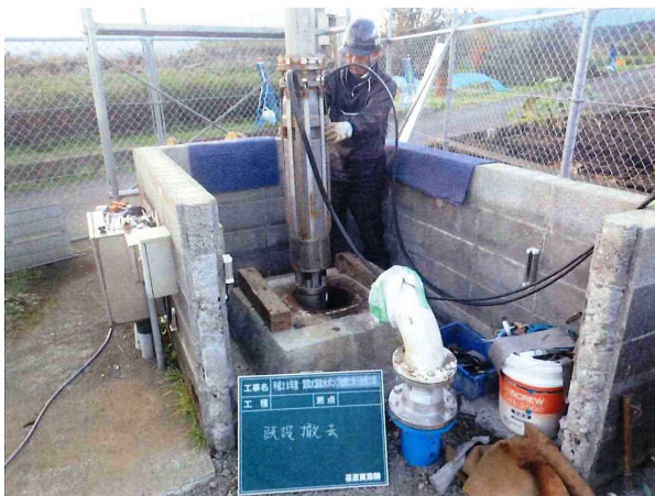
水源取水ポンプの入替作業（貫水水源）
