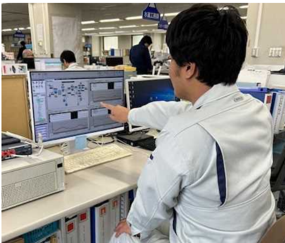
テレメータ装置による水道施設の監視
