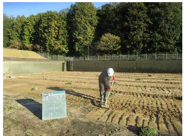
北山浄水場緩速ろ過池の汚砂削取作業
