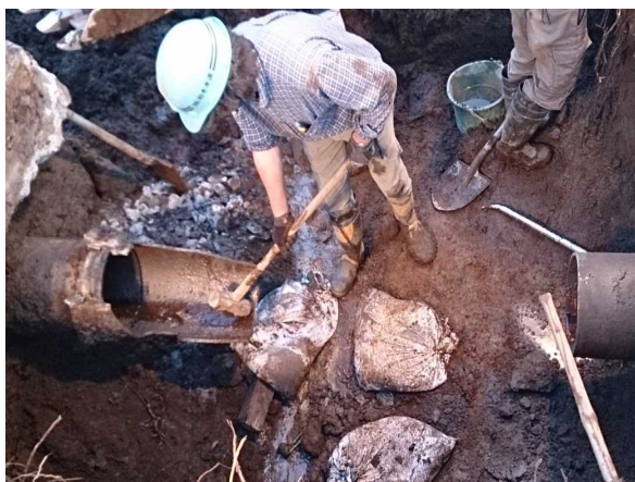
緊急の漏水修繕
