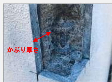
はつり調査及び鉄筋のかぶり厚さ
