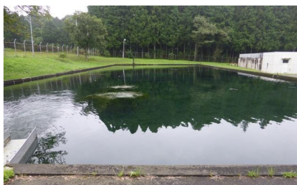
図 3-7 上井出浄水場（沈砂池）
