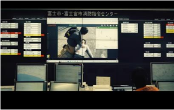
映像通報システム使用時の指令センター
