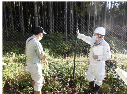
写真 29 被害防止設備の設置
