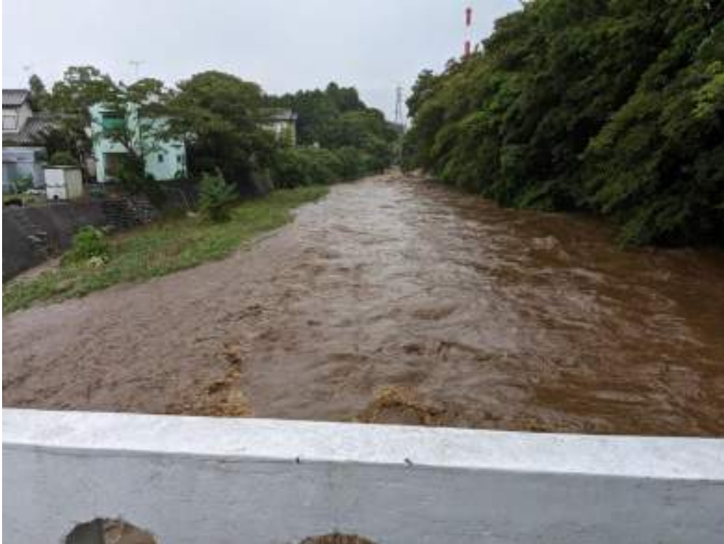
2021(令和3)年8月 一級河川潤井川の増水状況(横巻橋(山本地区))
