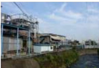
潤井川沿いの工場
