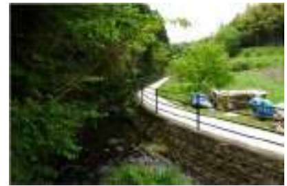
南沢ホテルのせせらぎ広場
