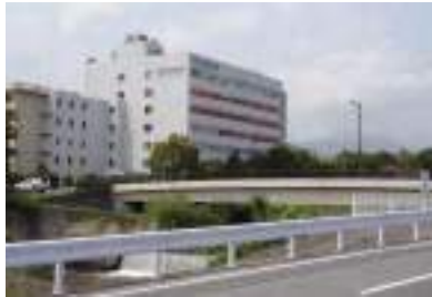
潤井川沿いの工場
