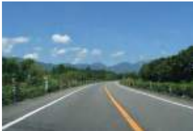
上井出インターチェンジ以北の区間
