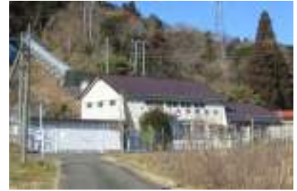
芝川沿いの発電所
