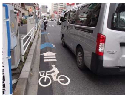
車線内に矢羽根型路面標示を設置した事例
