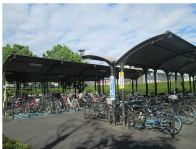
屋根や照明の設置 (富士宮駅南)
