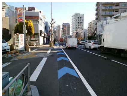
路肩内に矢羽根型路面標示を設置した事例
