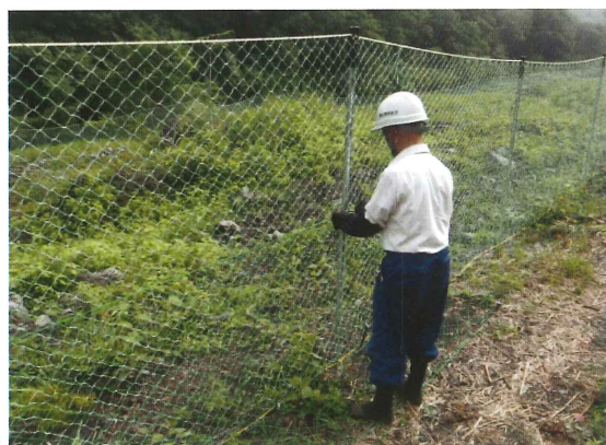
■ 防護柵設置（相野）
