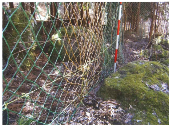
■ 防護柵補修（相野）
