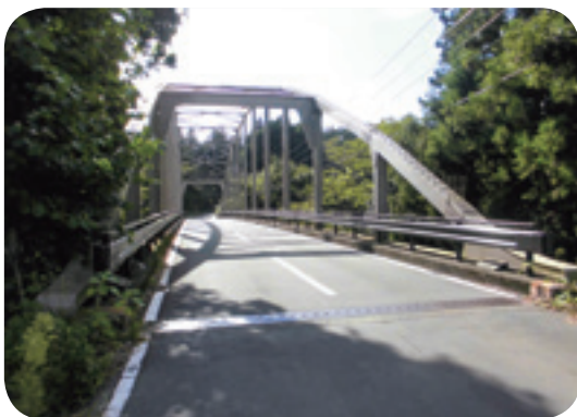
橋りょう長寿命化修繕事業 (狩宿大橋)
