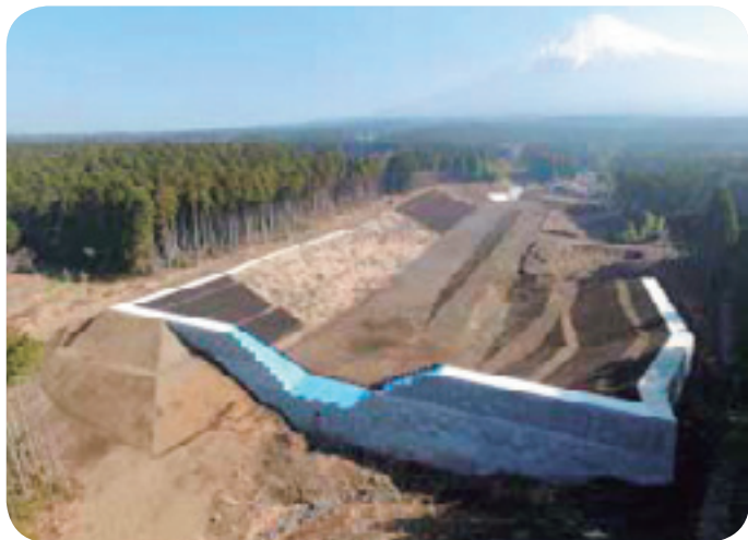
富士山土砂災害対策のための砂防工事
