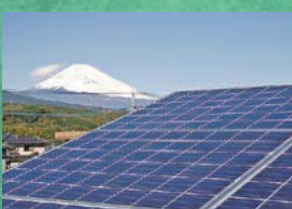
▲裾野市庁舎の太陽光パネル
