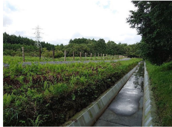
写真 13-6-5 水路止水中の豪雨後の状況 (水路底での自噴湧水、山側のり面からの湧水と水路貯水)
