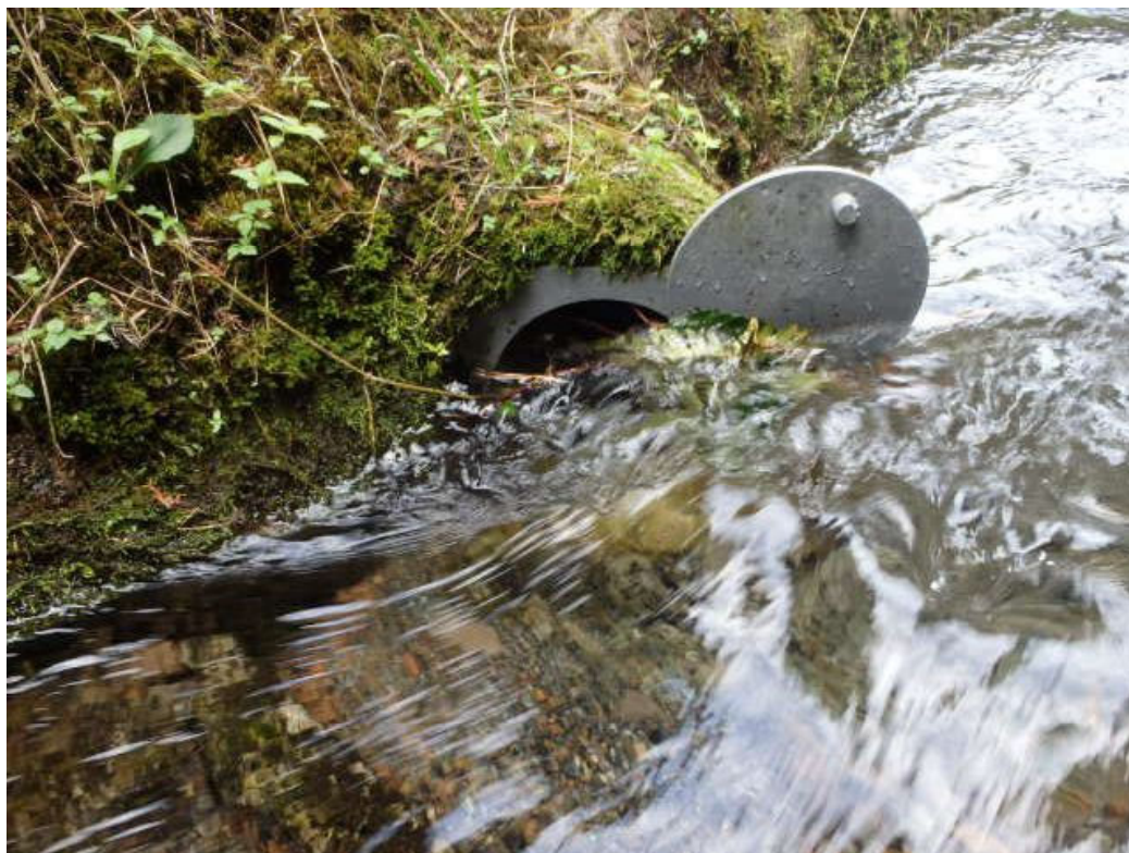
写真 4-6-15 (湿原への暗渠への用水路からの呑み口)
