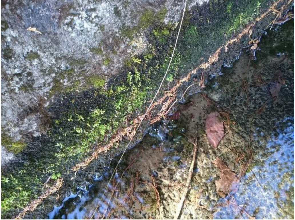
写真 4-6-20 (用水路底面脇、山側から湧水；クラックからのパイピング)
