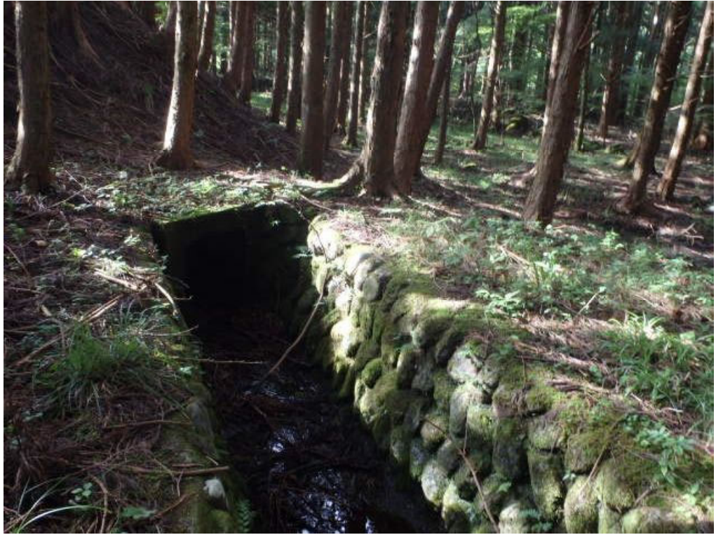
写真 4-6-10 (人工水路；コンクリート水路から暗渠で石張り水路へ)
