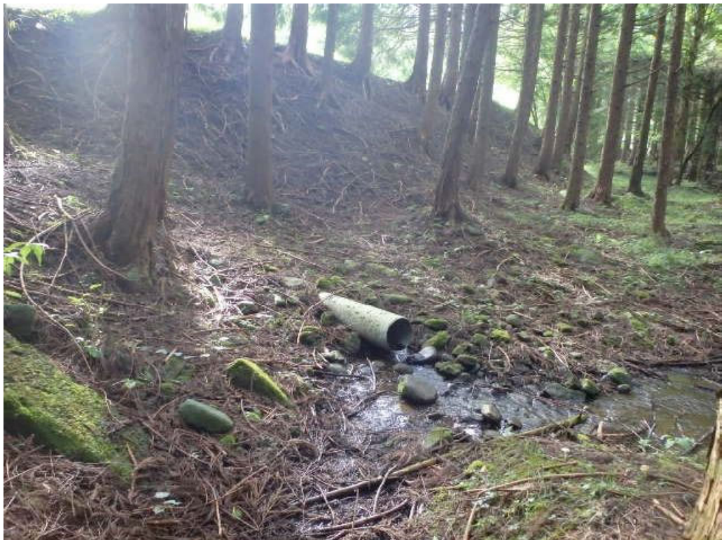
写真 4-6-13 (コンクリート水路から導水～地表面へ)
