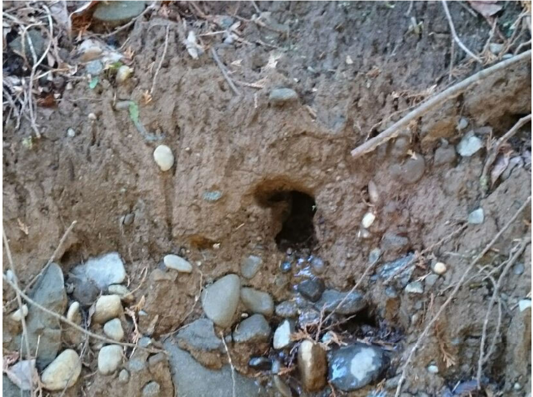
写真 4-6-34 ローム内で地下水によるパイピング（下位の砂礫層は帯水層）
