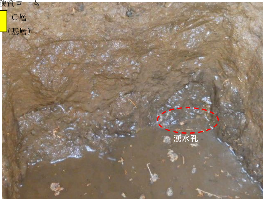
図 7-1-4. 試掘内写真（硬質ローム中 \phi 30mm くらいのホール開口亀裂孔）からの湧水
