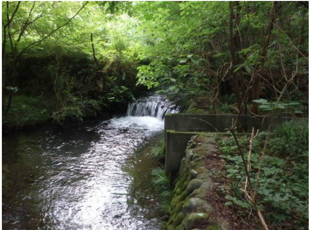
写真 4-6-7 (降雨後の流量は多い)
