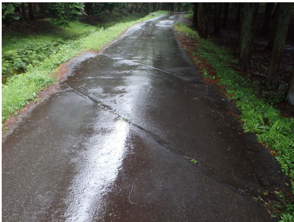
写真 4-6-14 (現道暗渠により小田貫湿原へ導水)
