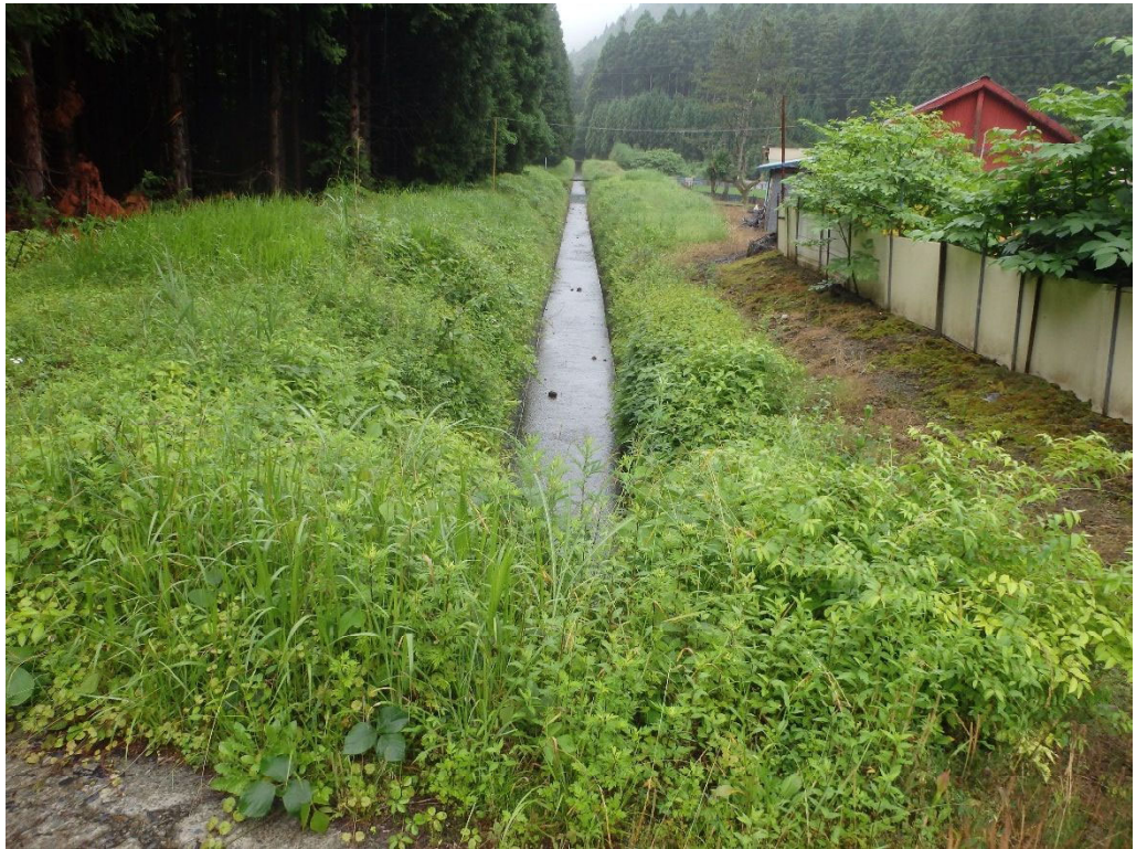
写真 4-6-8 (人工水路；スギノ沢より引き込み)
