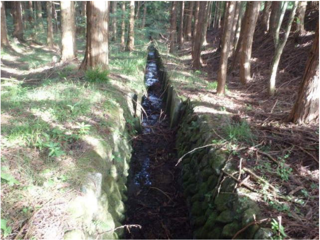
写真 4-6-11 (人工水路；石張り水路へ)
