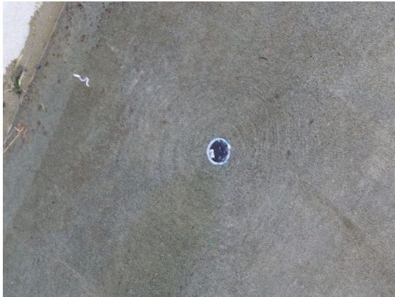
写真 13-6-5 水路止水中の豪雨後の状況 (水路底での自噴湧水、山側のり面からの湧水と水路貯水)
