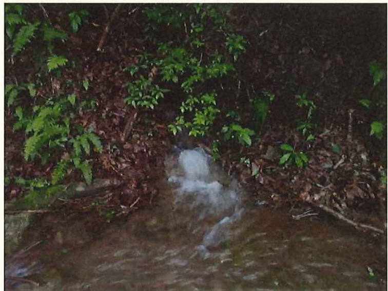
大量の岩盤亀裂からの湧水 2020/9/7 撮影（最大雨量日）
