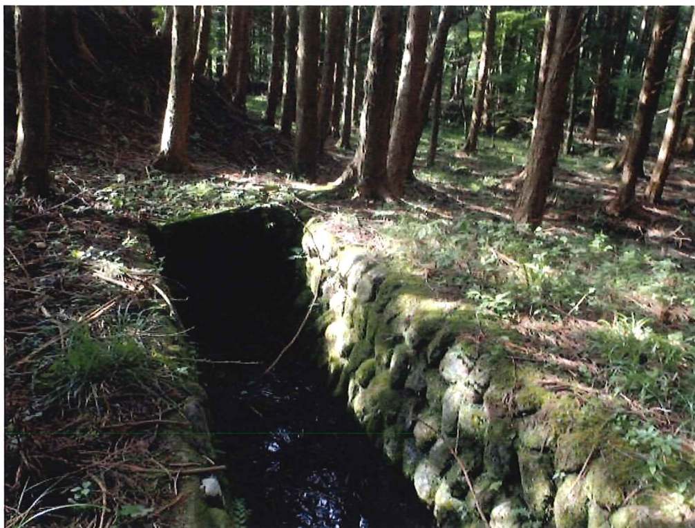
写真-10 (人工水路；コンクリート水路から暗渠で石張り水路へ)
