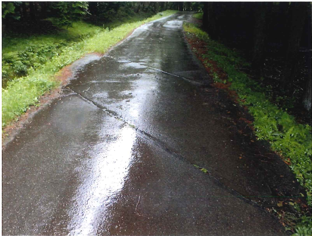
写真-14 (現道暗渠により小田貫湿原へ導水)
