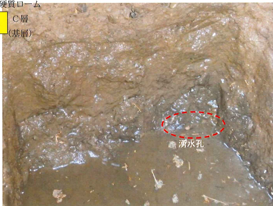
図 7-1-4. 試掘内写真（硬質ローム中φ30mm くらいのホール開口亀裂孔）からの湧水
