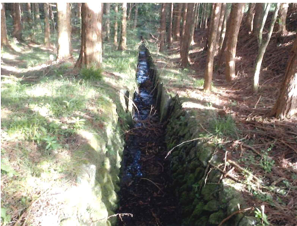
写真-11 (人工水路；石張り水路へ)
