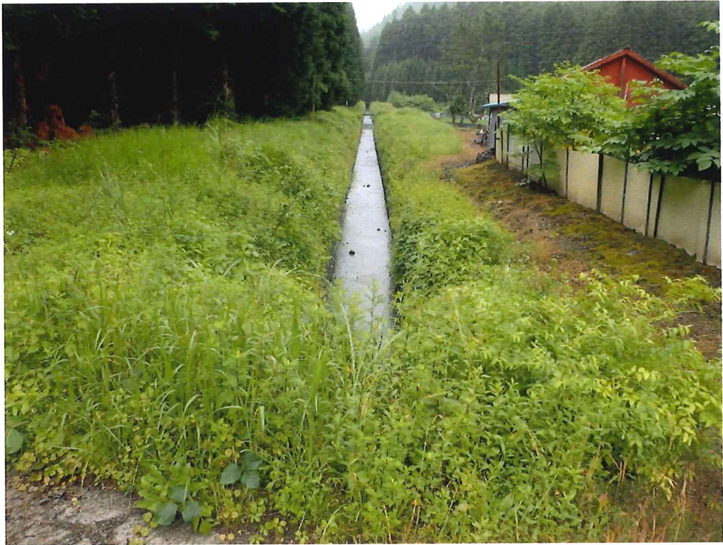
写真-8 (人工水路；スギノ沢より引き込み)
