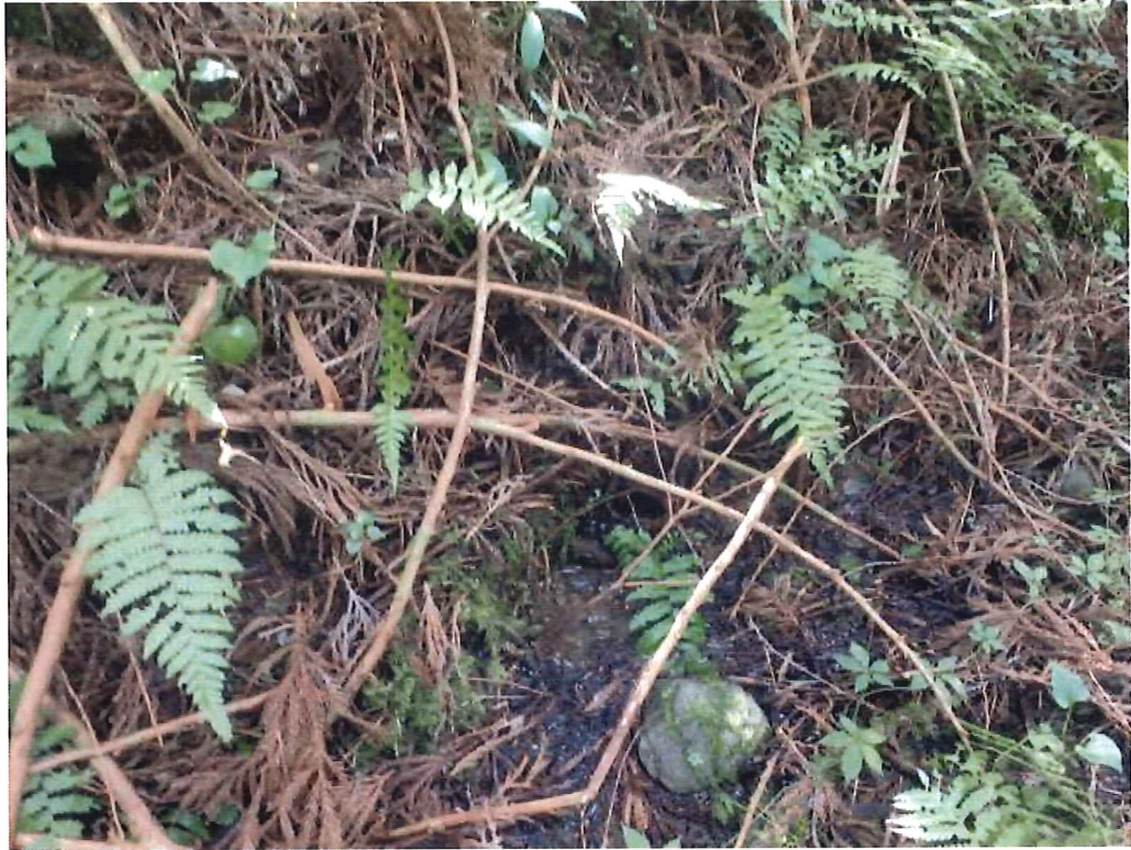
写真-12 (コンクリート水路からの漏水)
