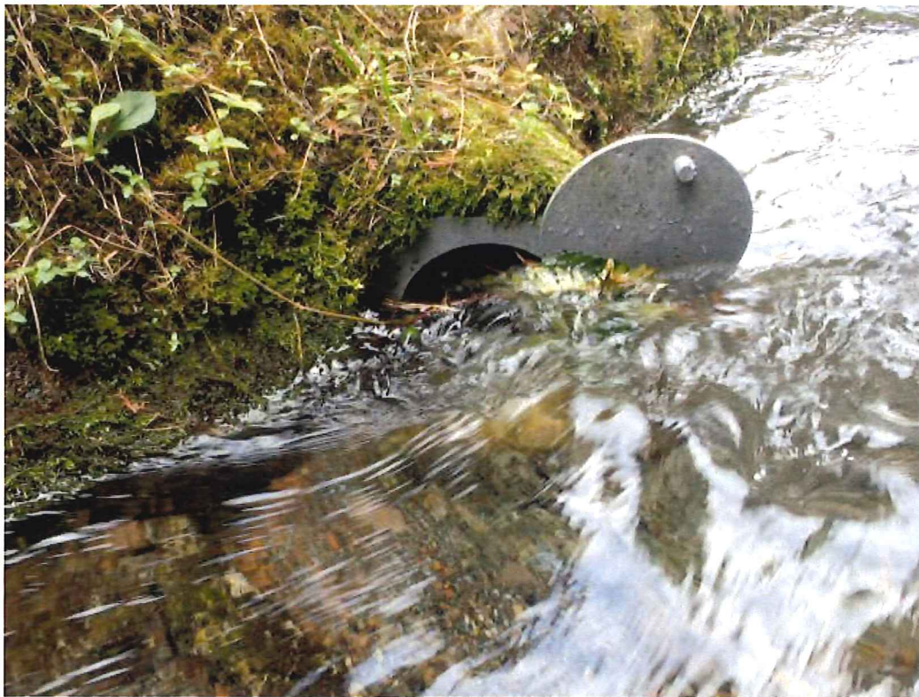
写真-15 (湿原への暗渠への用水路からの呑み口)
