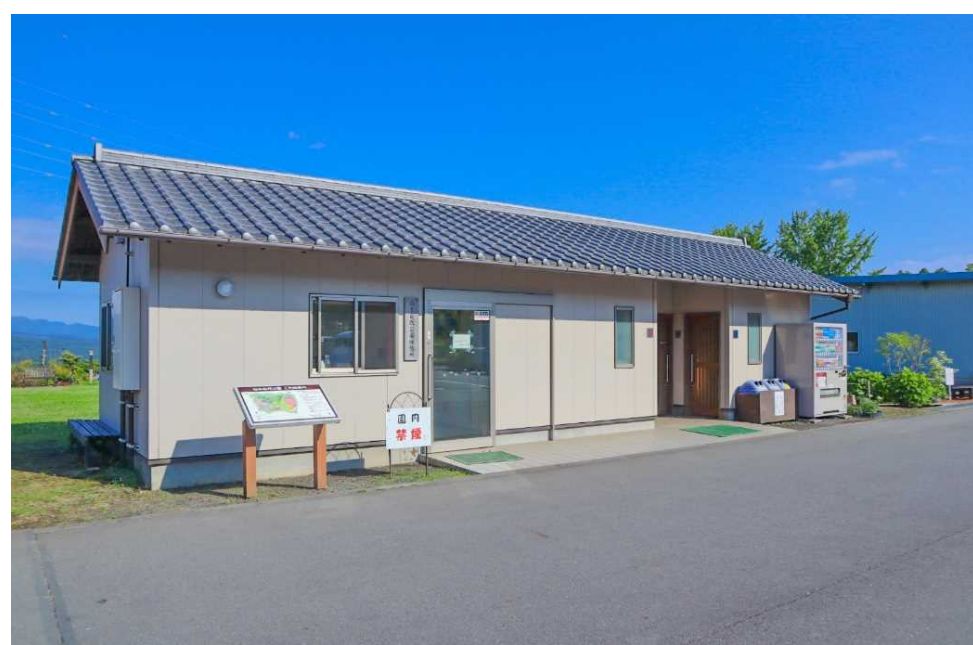
休憩室とトイレ
