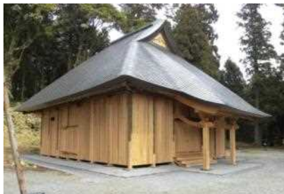
工事完了の外観
