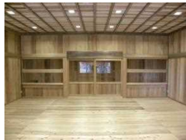
工事完了の内観
