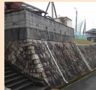
増し積み擁壁
