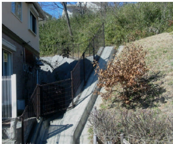
擁壁の設置によるがけの補強例
