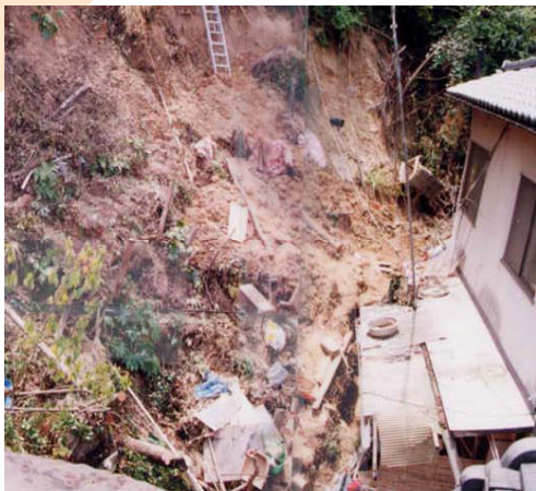
がけ崩れによる住宅被害
