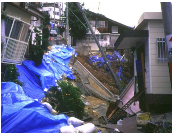
滑動崩落による被害状況（兵庫県南部地震）
