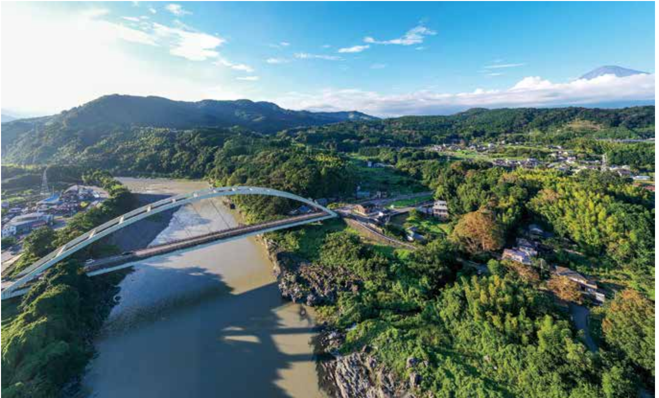
写真1-30A 空から見た富士川の蓬莱橋
