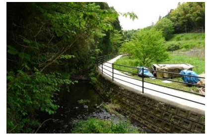
南沢ホテルのせせらぎ広場
