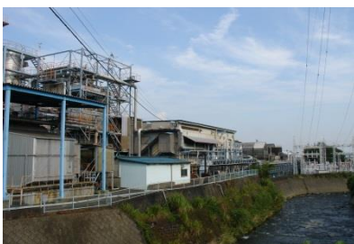
潤井川沿いの工場
