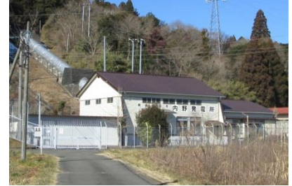
芝川沿いの発電所
